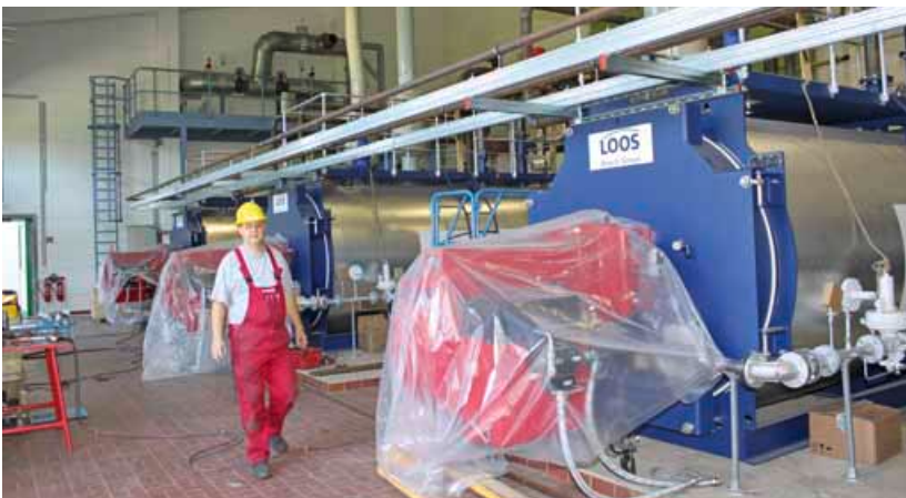
Drei neue Heißwasserkessel wurden in die Poststraße geliefert.
