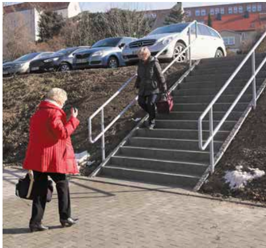
Die neue Treppe vom höher gelegenen Parkplatz sorgt für einen sicheren Weg zur Schwimmhalle.
