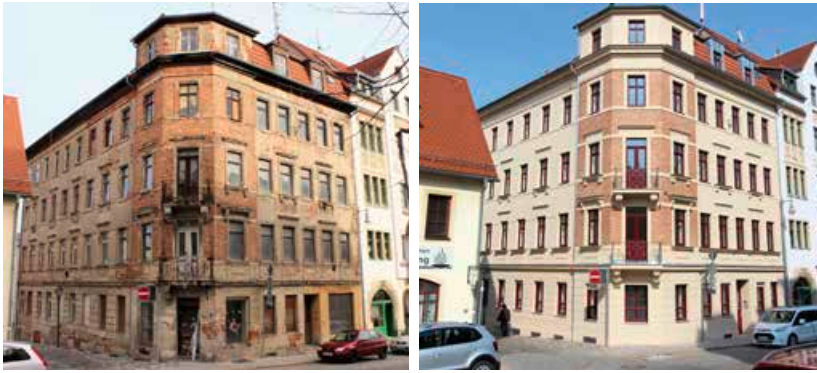
Die Sanierung eines denkmalgeschützten Hauses aus der Gründerzeit ist naturgemäß eine anspruchsvolle Aufgabe. Nach einjähriger Bauzeit erstrahlt das Gebäude in der Schmöllschen Straße 6 in neuem Glanz.
