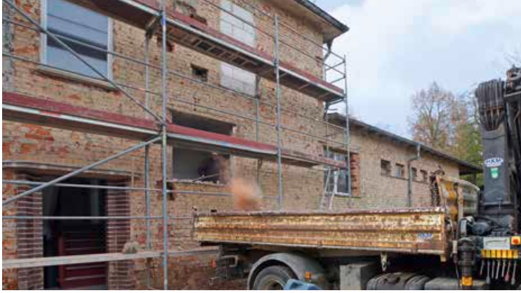
Die Ewa nutzt die Wintermonate für Bauarbeiten im Freibad wie die Sanierung der Fassade des Wirtschaftsgebäudes.
