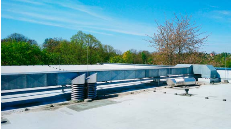
Zur Beseitigung von Undichtigkeiten am Flachdach des Hallenbades wird die alte Dachdeckung ausgetauscht und das Dach entsprechend neu gedämmt.
