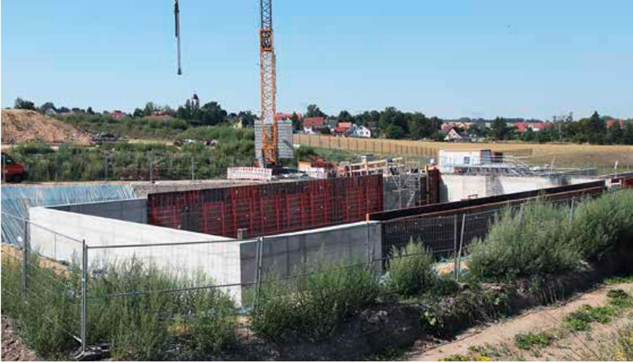
Die komplexe Erschließung des Gewerbegebietes Poststraße führte zu einer kompletten Neugestaltung des Abwassersystems getrennt in Schmutz- und Regenwasser. Als letztes großes Teilprojekt wird derzeit ein Mischwasser-Rückhaltebecken errichtet, das zusätzlich zu dem bereits im Jahr 2020 gebauten Regenrückhaltebecken „An der Schmiede“ entsteht.
