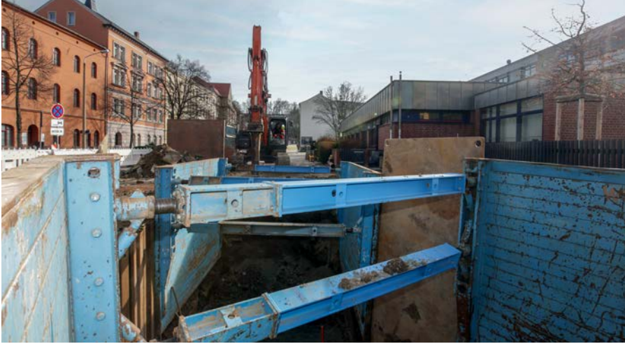
Bei der Sanierung der Kanalisation in der Johann-Sebastian-Bach-Straße müssen die Abwasserrohre komplett neu verlegt werden.
