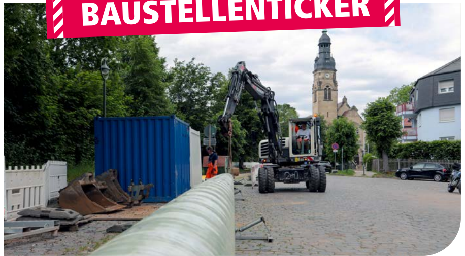
Verlegung einer neuen Gashochdruckleitung im Eselsweg – Fertigstellung bis Ende Juni
